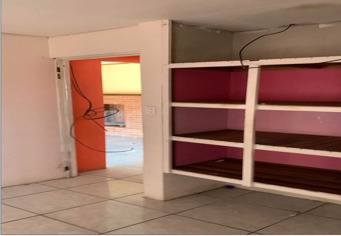
Descripción: Vista dormitorio
