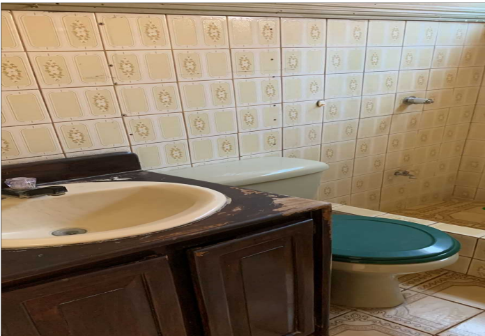
Descripción: Vista interna de baño
