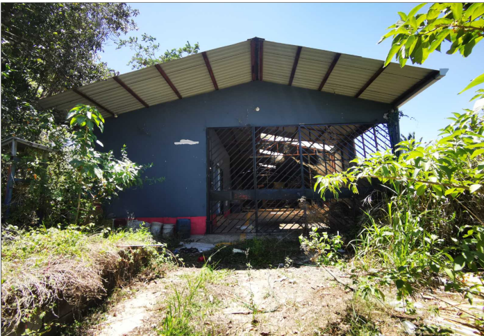
Descripción: FACHADA DE LA BODEGA
