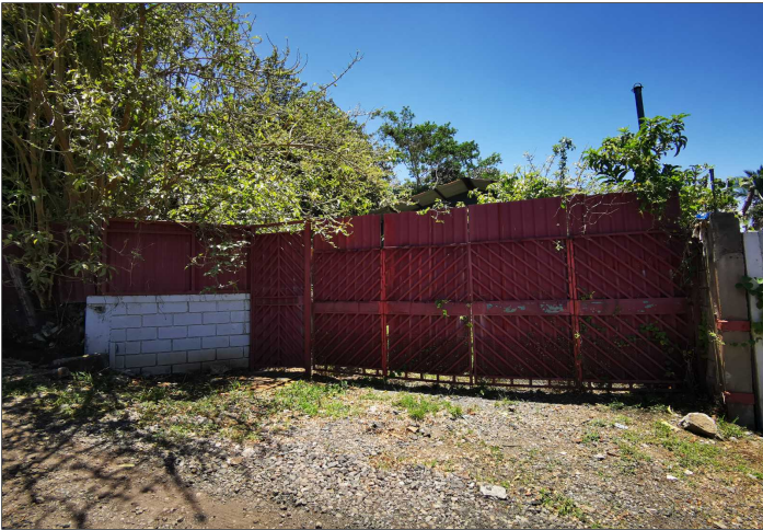
Descripción: INGRESO A LA BODEGA
