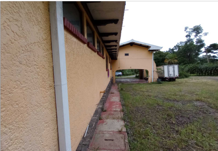
Descripción: Vista lateral oeste
