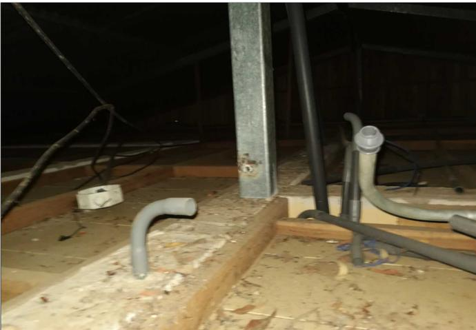
Descripción: Estructura de Techo, se observa que el cableado eléctrico fué removido.
