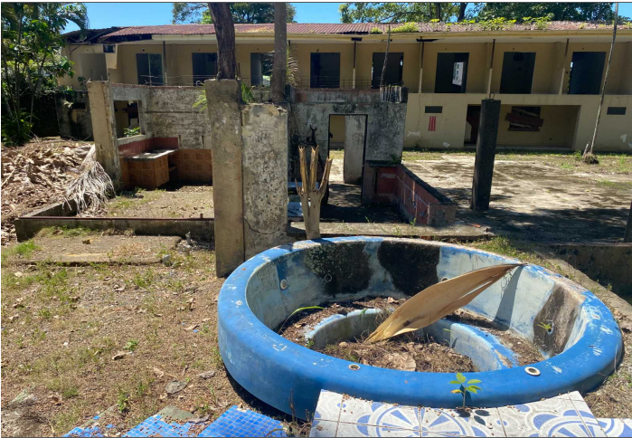
Descripción: PISCINA 02 / RANCHO Y EDIFICIO DE HABITACIONES AL FONDO
