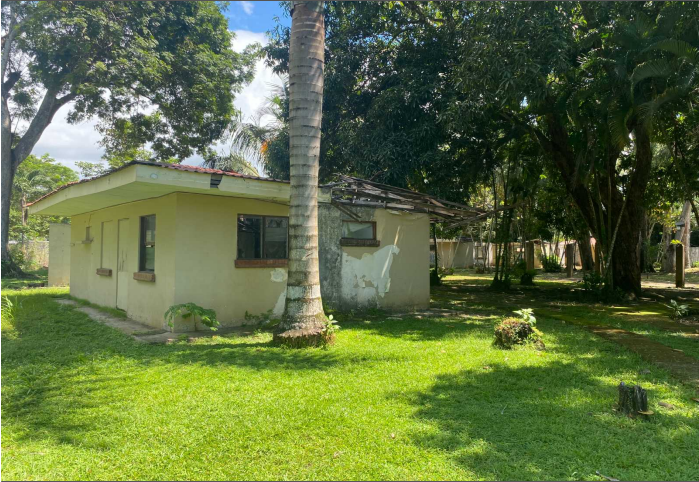
Descripción: INTERNA / CABINAS
