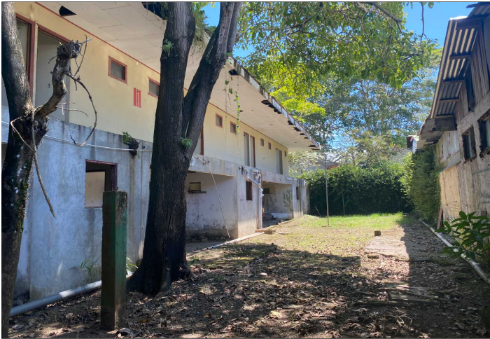
Descripción: VISTA POSTERIOR EDIFICIO DE HABITACIONES / LINDERO OESTE
