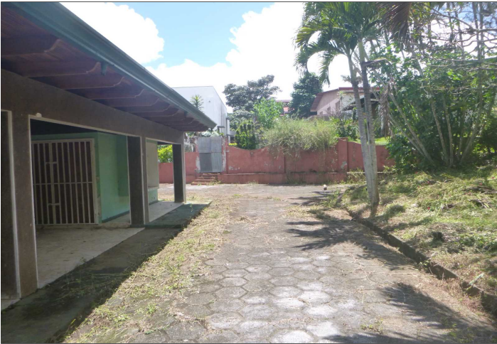
Descripción: Calle de acceso interior
