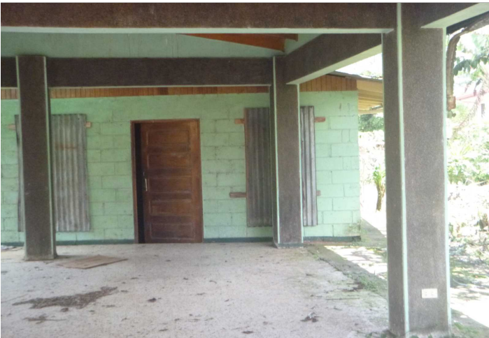
Descripción: Vista cochera y bodega
