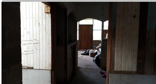
Vistas parciales del interior de la propiedad. Cocina de la obra.
