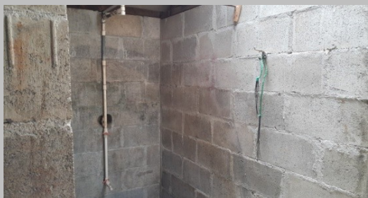
Vistas parciales del interior. Baño de la obra.
