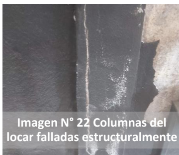
Imagen N° 23 Columnas del locar falladas estructuralmente
