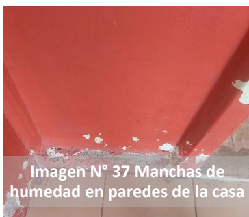
Imagen N° 38 Manchas de humedad en paredes de la casa
