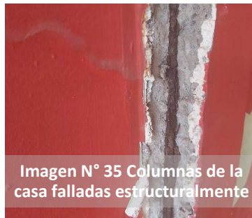
Imagen N° 34 Columnas de la casa falladas estructuralmente
