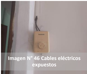
Imagen N° 43 Cables eléctricos expuestos
