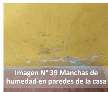
Imagen N° 38 Manchas de humedad en paredes de la casa
