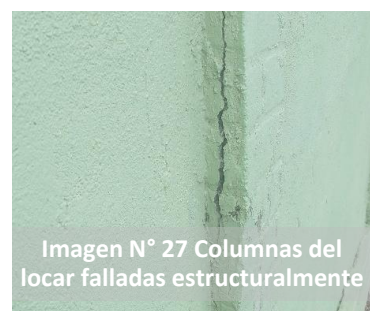
Imagen N° 26 Columnas del locar falladas estructuralmente
