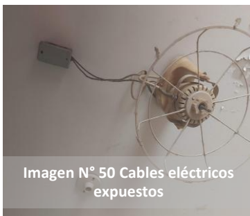
Imagen N° 47 Cables eléctricos expuestos
