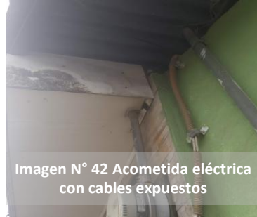
Imagen N° 41 Acometida eléctrica con cables expuestos
