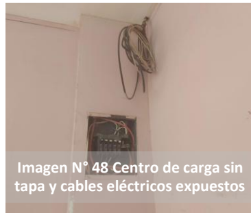
Imagen N° 45 Cables eléctricos expuestos
