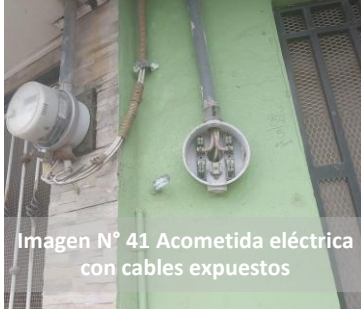
Imagen N° 42 Acometida eléctrica con cables expuestos
