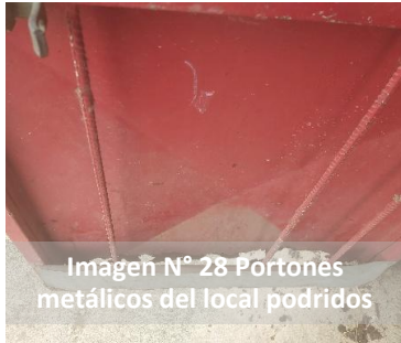
Imagen N° 29 Portones metálicos del local podridos
