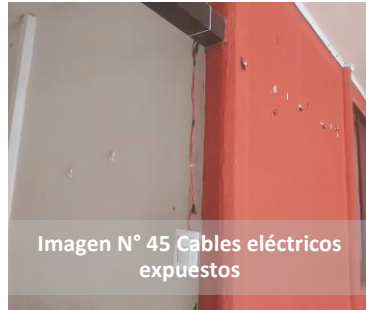
Imagen N° 42 Acometida eléctrica con cables expuestos
