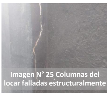
Imagen N° 22 Columnas del locar falladas estructuralmente
