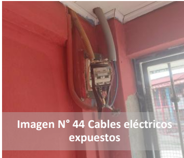
Imagen N° 41 Acometida eléctrica con cables expuestos
