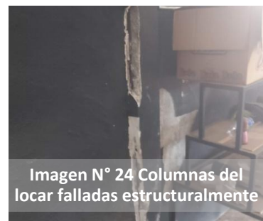
Imagen N° 23 Columnas del locar falladas estructuralmente
