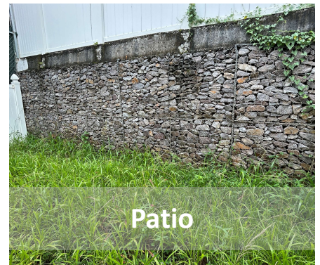
Área de pilas y patio
