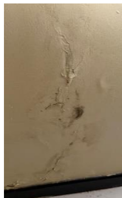
Vistas parte pared con presencia de humedad
