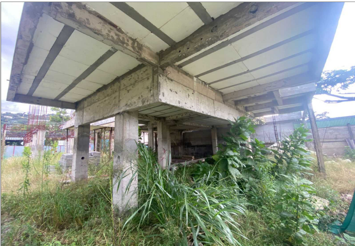
Descripción: Vista interior obra en construcción
