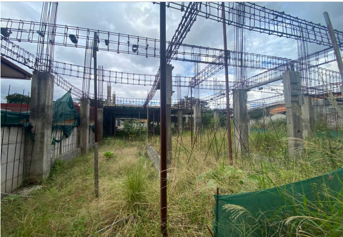
Descripción: Vista interior obra en construcción
