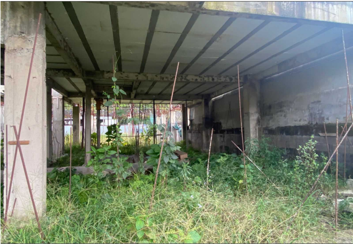
Descripción: Vista interior obra en construcción (entrepiso)
