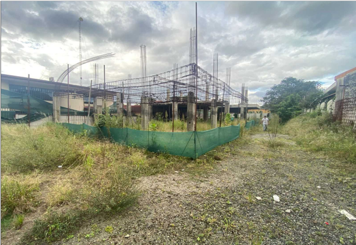
Descripción: Fachada obra en construcción
